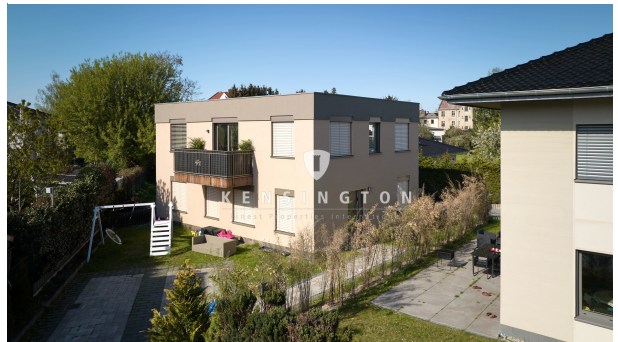
Außenansicht Haus Q
