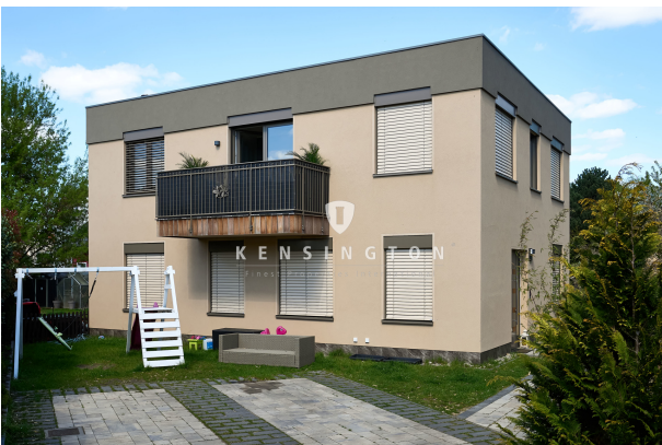
Außenansicht Haus Q
